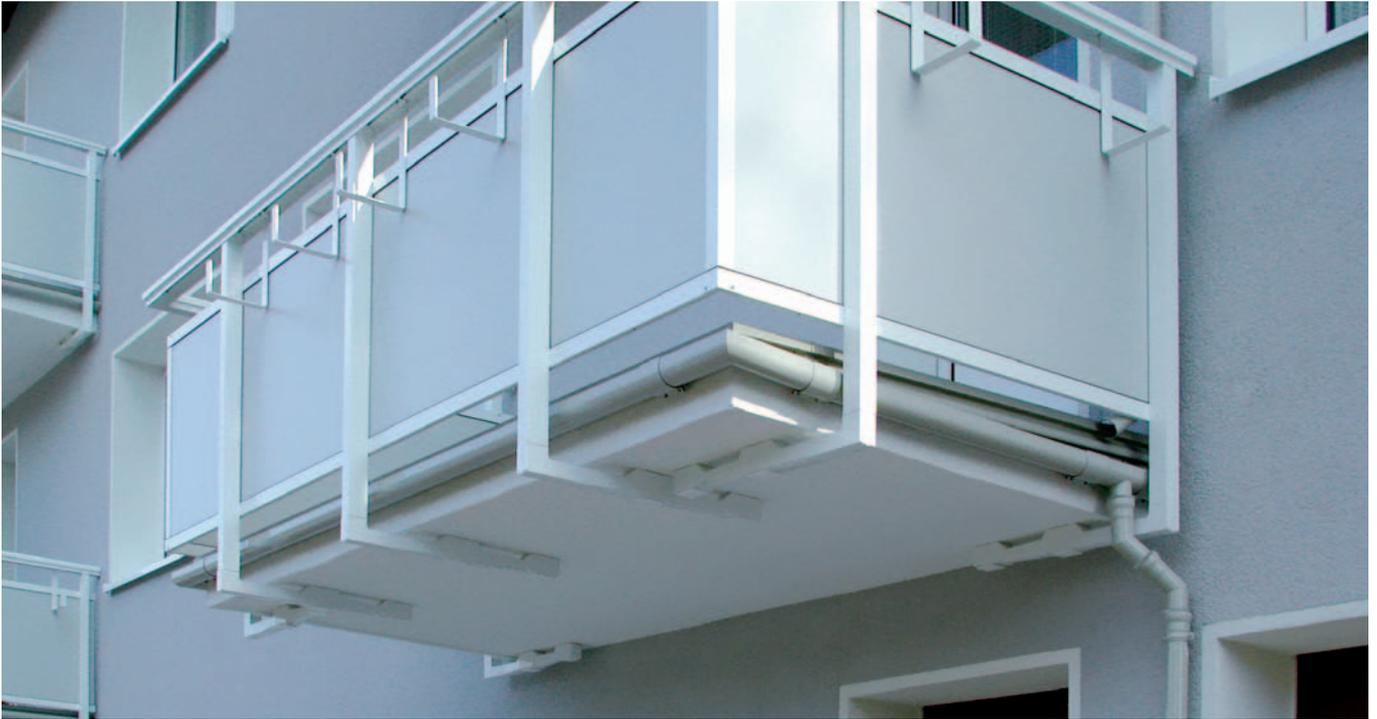
**Die innovative Stecktechnik ermöglicht eine einfache Montage – auch nachträglich.**
