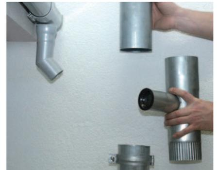
Mit dem ProRin® AL Fallrohradapter ist der Anschluss an bestehende Fallrohre problemlos möglich. Aus dem bestehenden Fallrohr wird einfach ein Teilstück entnommen und durch den Fallrohradapter ersetzt.
